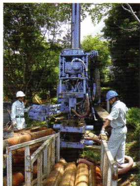
ボアホール掘削作業
